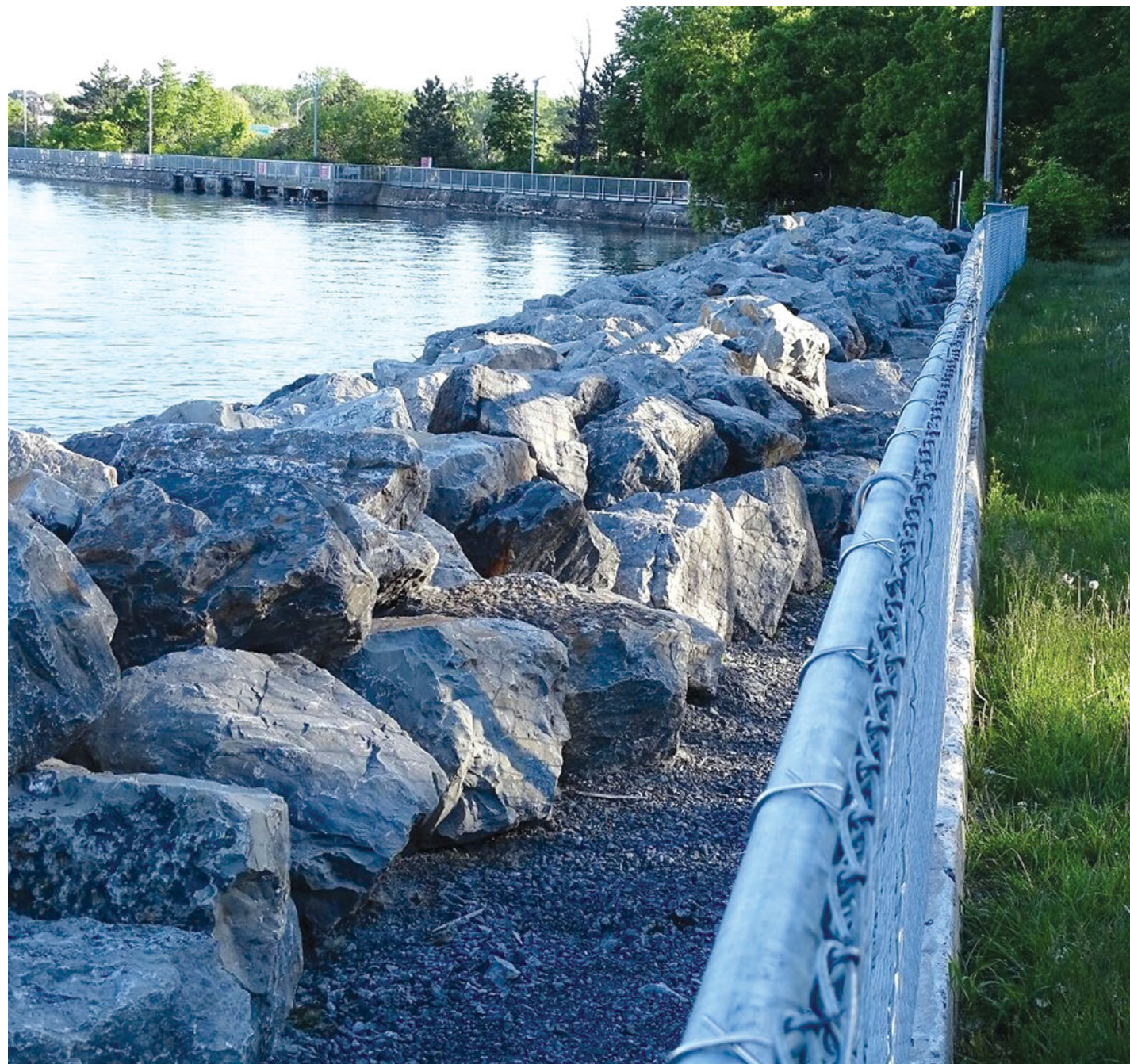
Remblai du mur de soutènement en amont du barrage Simon-Sicard. Photo : Archives / JDV
