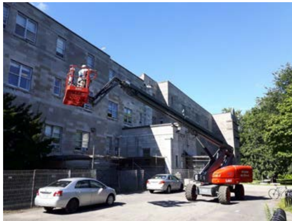
Les travaux ont commencé à l'école secondaire Sophie-Barat. (Photo : archives JDV)
