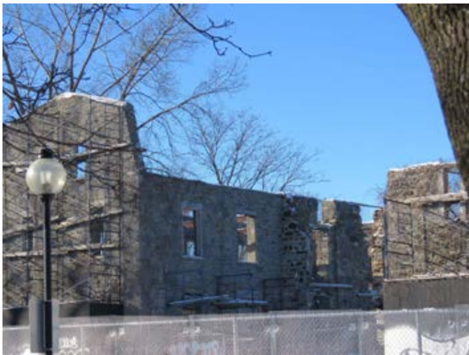
Les ruines de l'externat Sophie-Barat où auront lieu les travaux d'agrandissement. (Photo : archives JDV)
