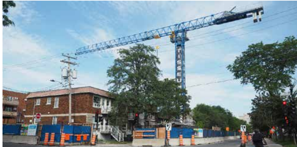
Les travaux de la STM à l'intersection de Berri et Chabanel dérangent le voisinage. (Photo : Camille Vanderschelden, JDV)
