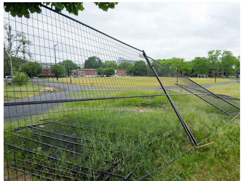
Les clôtures temporaires se sont effondrées dans la partie sud du parc Saint-Simon-Apôtre. (Photo : François Robert-Durand, JDV)
