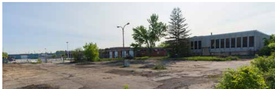
Le chantier du futur écoquartier Louvain Est se fait attendre. (Photo : François Robert-Durand, JDV)
