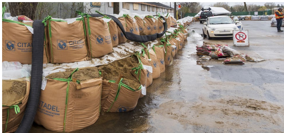
Des sacs de sable ont été installés sur la rue Cousineau. (Photo : François Robert-Durand, JDV)
