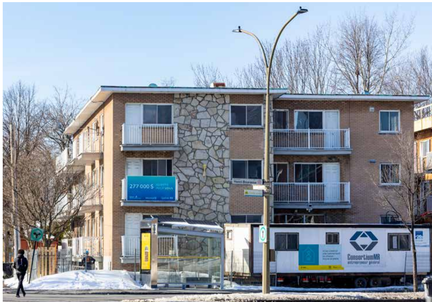
Travaux de rénovation au 2915, boul. Henri-Bourassa Est. (Photo : Toma Iczkovits, collaboration spéciale)
