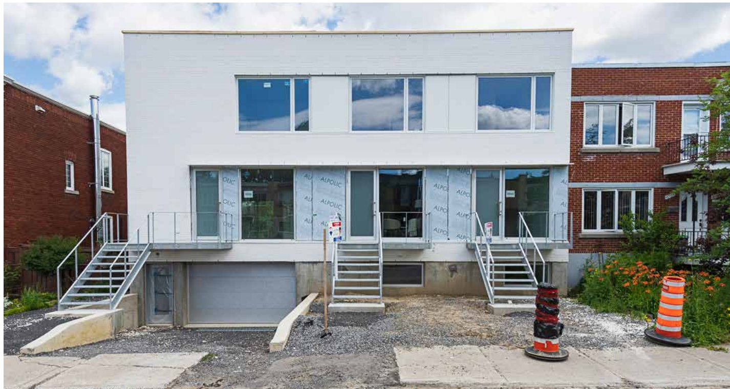
Au 10 147, av. Péloquin, une maison de type shoebox a été «avalée» par une nouvelle construction. (Photo : François Robert-Durand, archives JDV)
